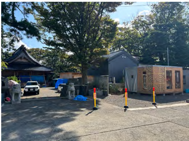
2024年10月 重蔵神社前に倉庫として設置
